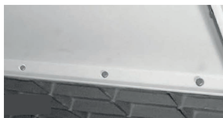
Afb. 12 Montage stalen verlengtafel
